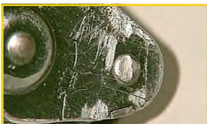
**激しく損傷したリベット (注意が必要)**
